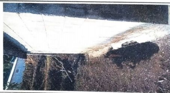
Foto 6: SUSTITUCIÓN DE CIMENTO PARA SANITARIO,
