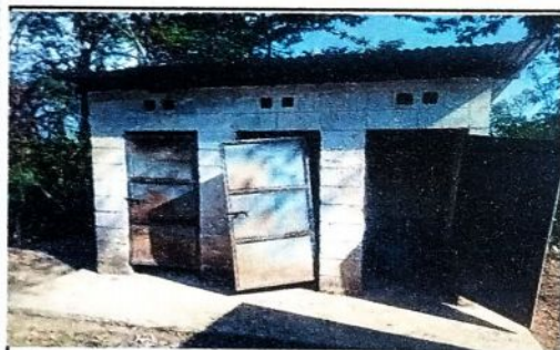
Foto 5: SUSTITUCIÓN DE: LETRINA, PUERTAS, LAMINAS Y PINTURA
